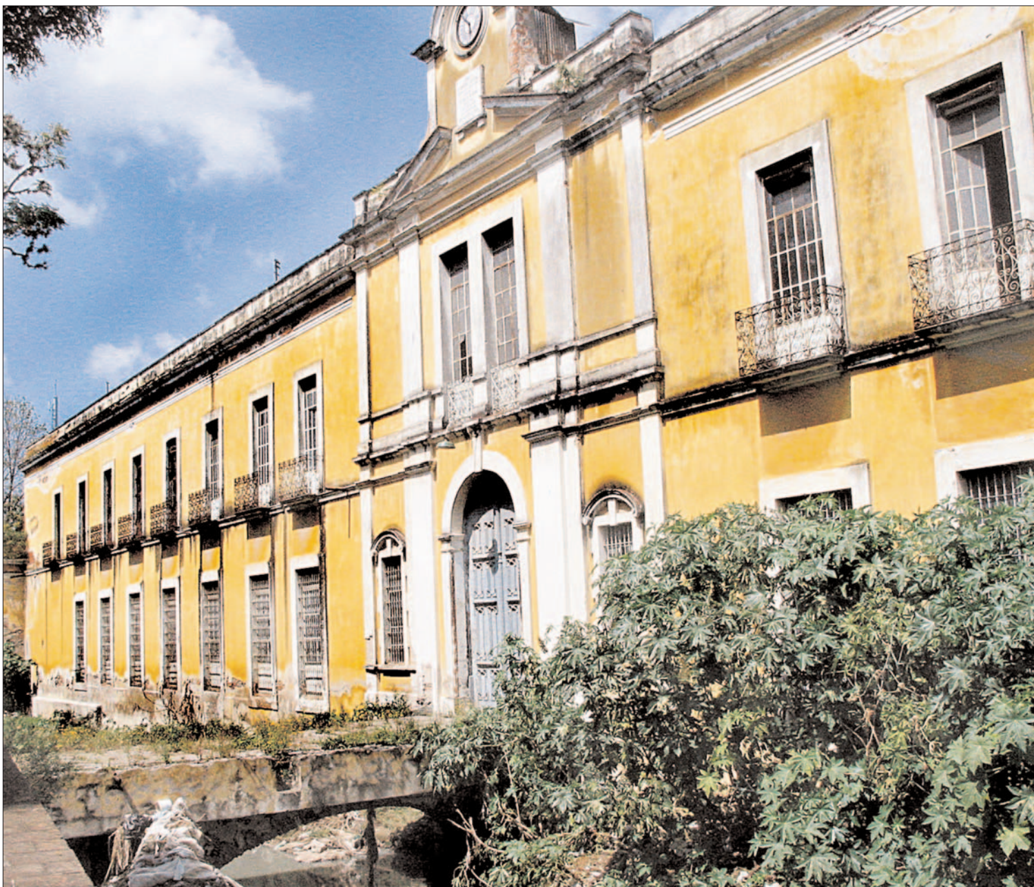
La etapa inicial de la rehabilitación consistirá en el apuntalamiento, la remodelación de pisos, columnas, herrería y otros ornamentos ■ Foto Abraham Paredes
